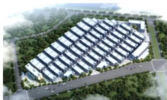
浙江·绍兴—友地金属智造产业园
