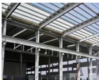
厂房仓库排水
