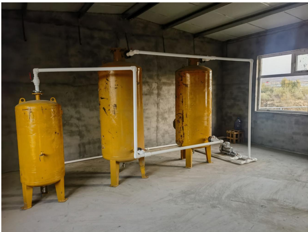
图4-3 沼气脱硫设施照片
