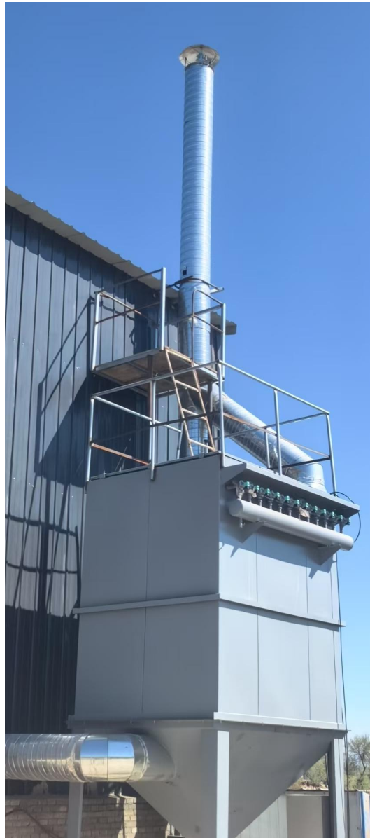
图 3-1 水泥砖生产线除尘器及排气筒照片
