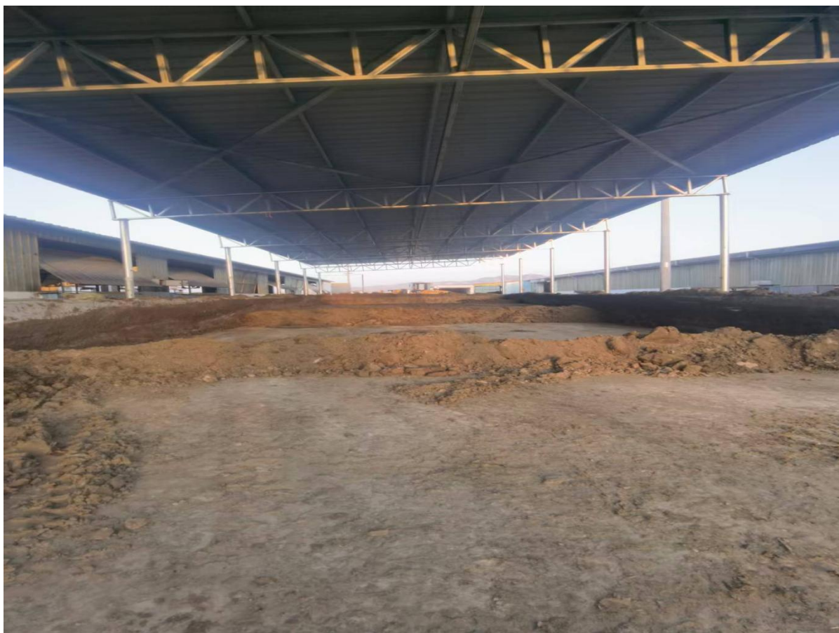
东区 3 个堆粪场
