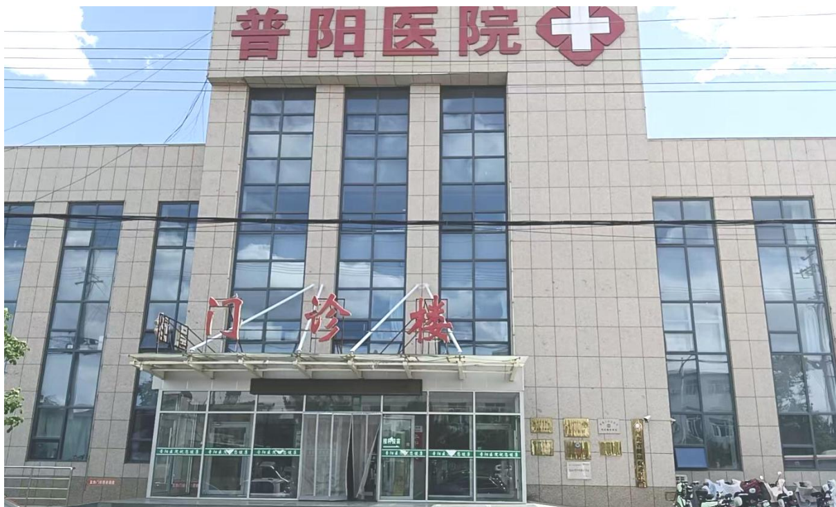
怀安普阳医院增加床位项目主体工程现场彩色照片
