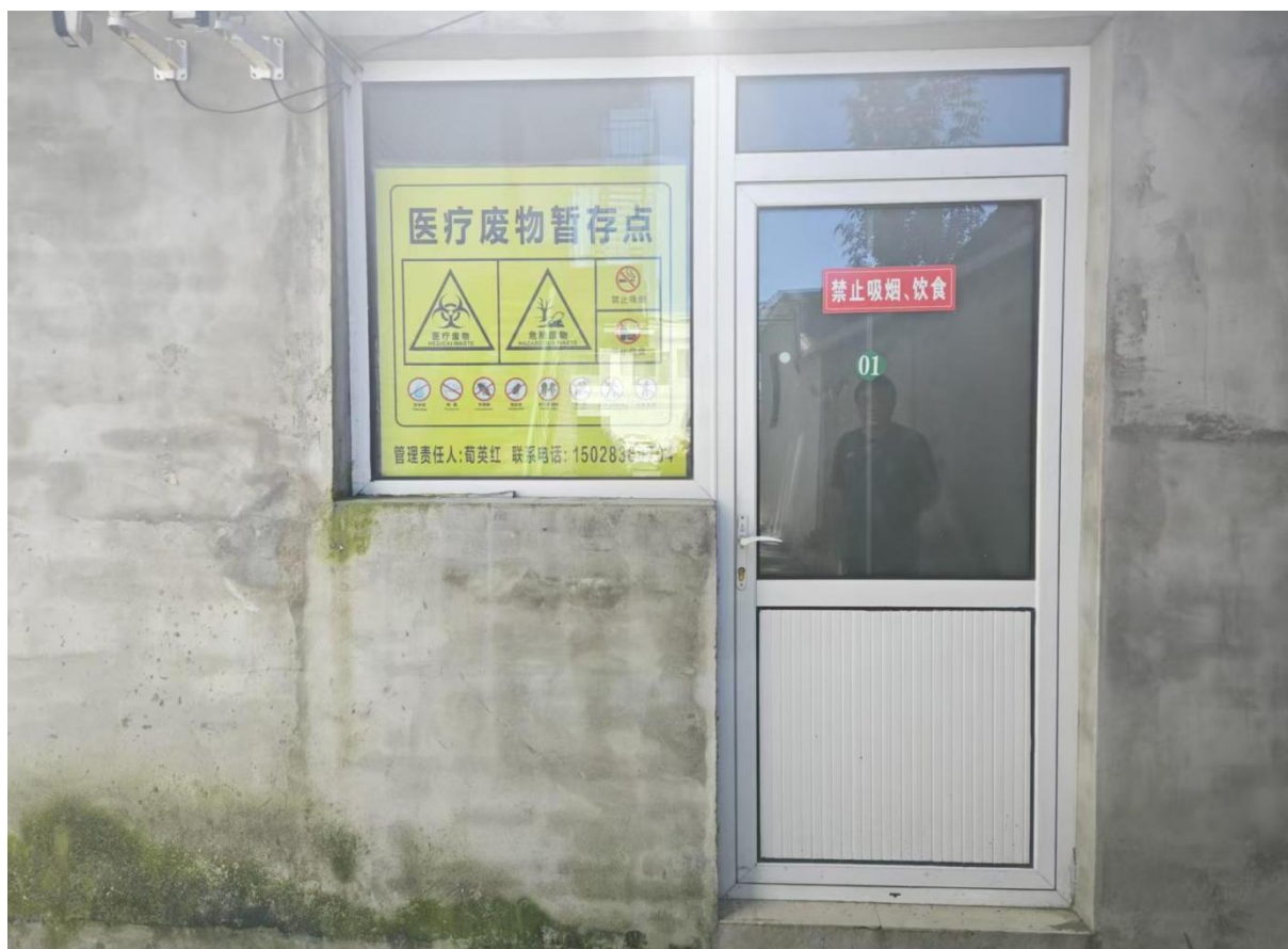
医疗废物暂存间
