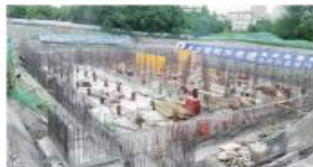
池州市海绵城市工程
