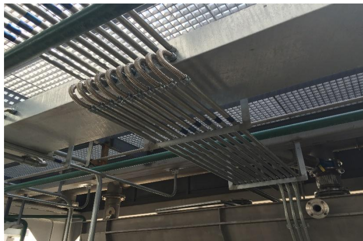
机电安装施工
