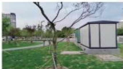
萍乡市海绵城市工程
